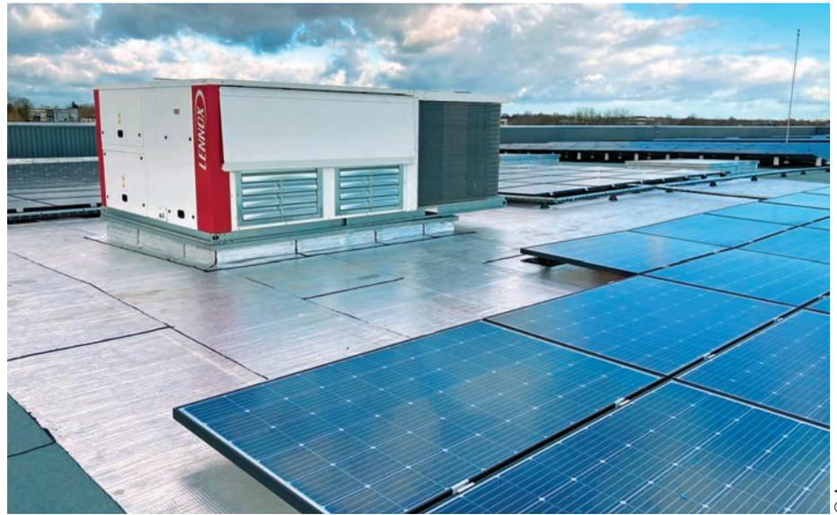
Unité de stockage d'énergie à batteries lithium-ion conçue pour les entrepôts AutOnom d'Argan.
