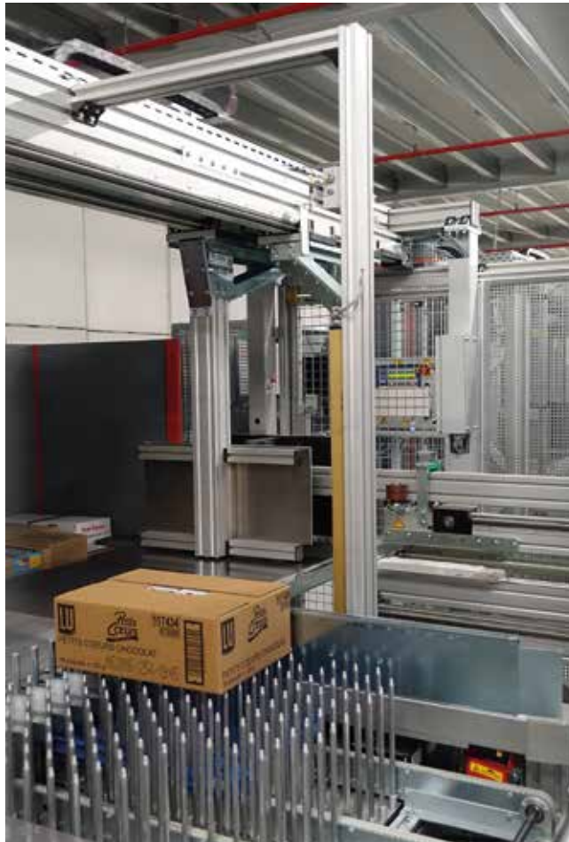
Scapet s'est doté d'un process Witron totalement automatisé de 43 000 m 2 de surface au sol à Recy, près de Châlons-sur-Marne.
