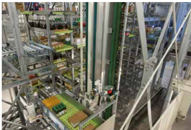
Entrepôt Migros à Suhr, en Suisse.
