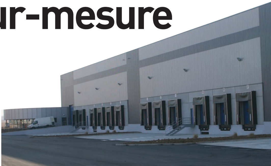
Cet entrepôt de 18 000 m 2 construit fin 2008 à Montéler par Concerto Développement est l'une des dernières opérations en blanc de la région.
